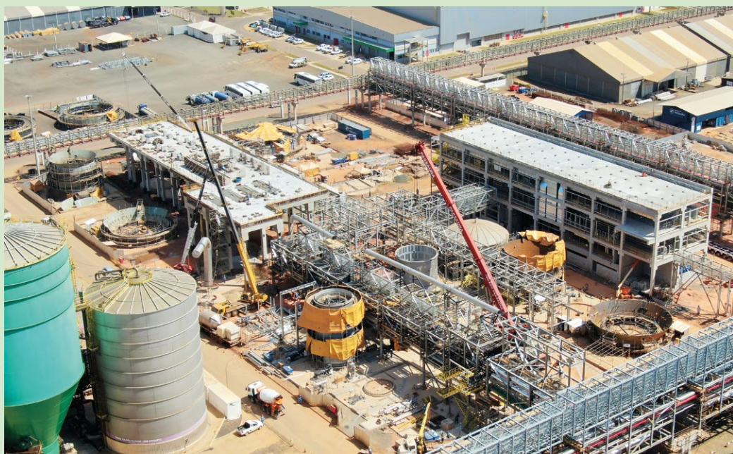
Construção da linha de fibras do projeto Puma II.
